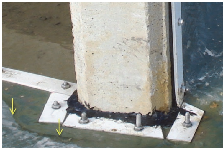
Figure 1. Raccordement défectueux par plat alu + tassement du support (flèches)
