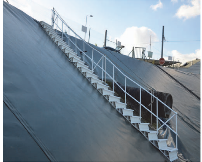
Figure 33. Escalier avec 1 main courante
