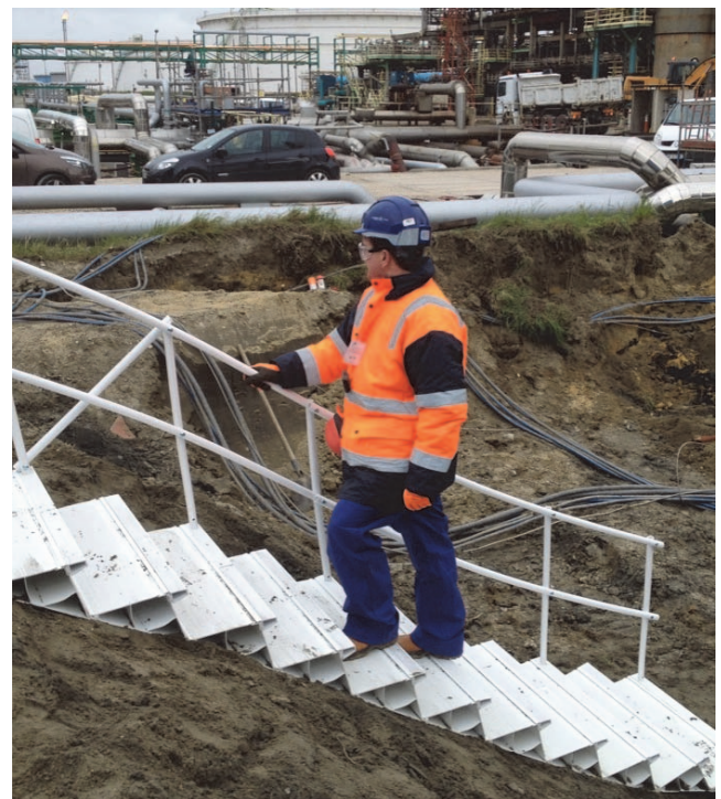
Figure 35. Escalier en utilisation provisoire
