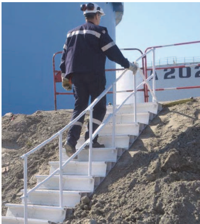
Figure 34. Escalier sur un site pétrolier
