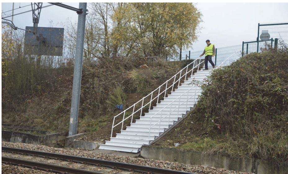
Figure 36. Accès pour l'entretien des voies SNCF – Marches de 2m de large
