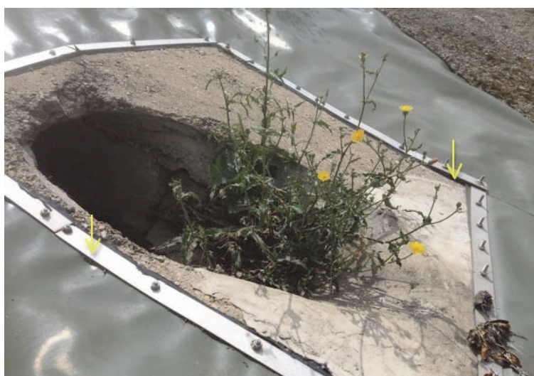
Figure 2. Problème de planéité du support
