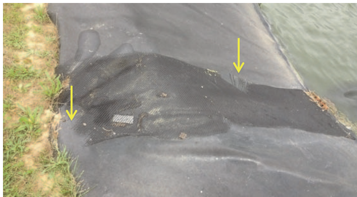
Figure 27. Géospaceur attaqué par les UV
